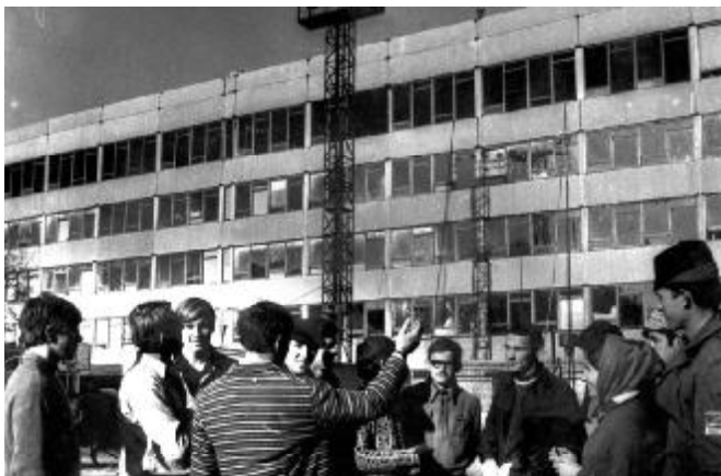
Будівництво лабораторного корпусу по вул. 40-річчя Радянської України. Студентський будівельний загін уточнює завдання
